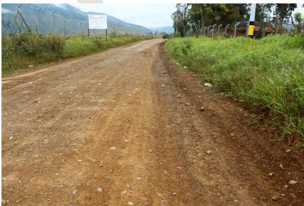
Figura 1. Antes de aplicar los materiales en tramo
