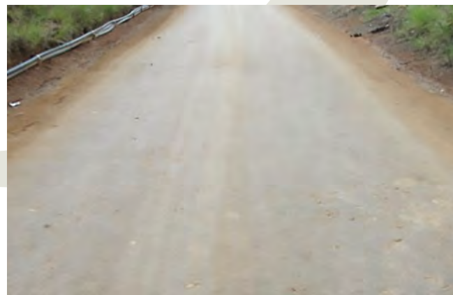
Figura 2. Después de aplicar los materiales en tramo.
