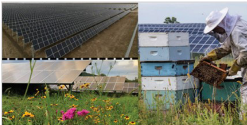
Figura 2. Implementación de un sistema agrivoltaico en conjunto con un colmenar de abejas en la granja Aurora solar, Minnesota.
