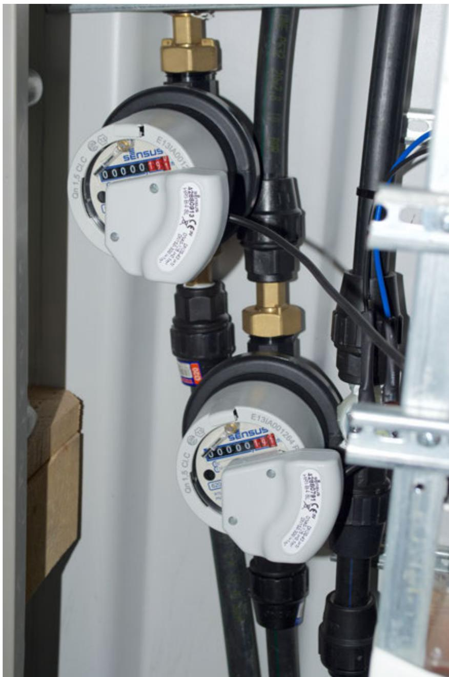
Figura 9. Contador de agua para medir el caudal de entrada a cada humedal del piloto
