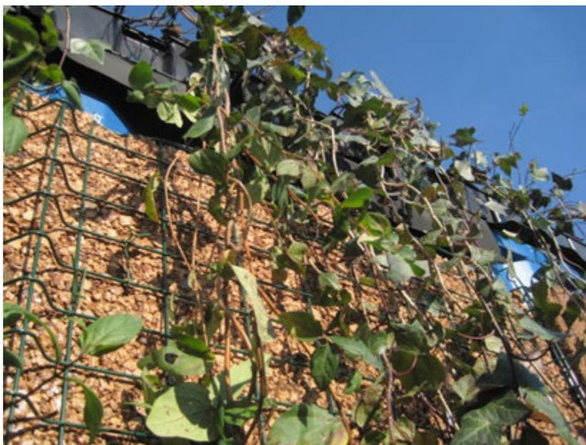
Figura 4. La pared vegetal, en combinación con el corcho, permite tener temperaturas en verano, dentro del contenedor, cercanas a los 29°C.
