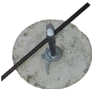
Figura 5. Falla del acero en anclaje estructural posinstalado
