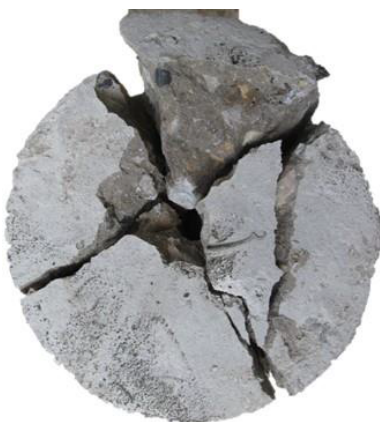
Figura 4. Falla por rotura del concreto en anclaje estructural posinstalado
