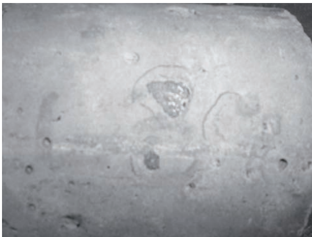
Figura 13: Descascamiento de la pasta.
